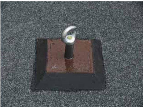
Фото 51 Устройство герметизации анкера с использованием полимерной рамки.
