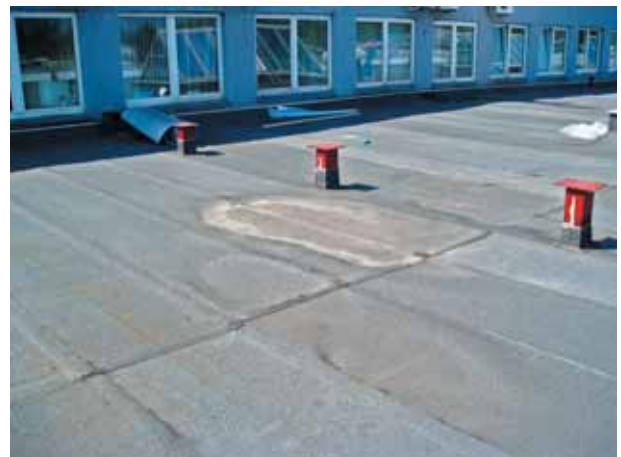
Фото 24 Отсутствие разбежки торцевых швов
