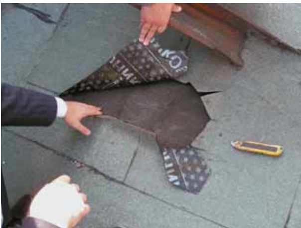
Фото 23 Отсутствие деформации индикаторного рисунка
