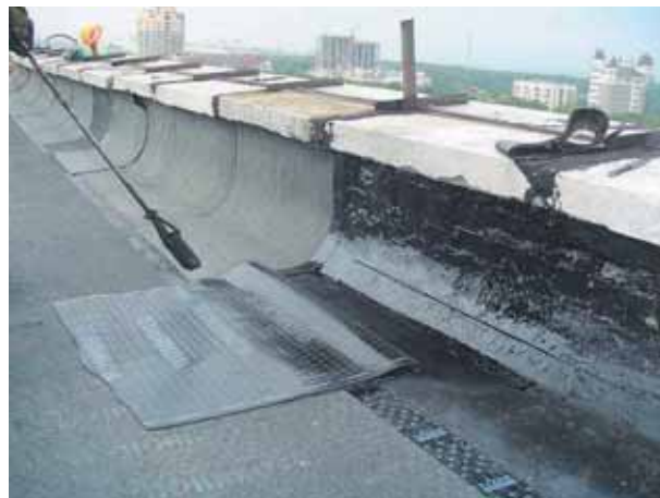
Фото 39 Разогрев кровельного ковра после прогрева основания
