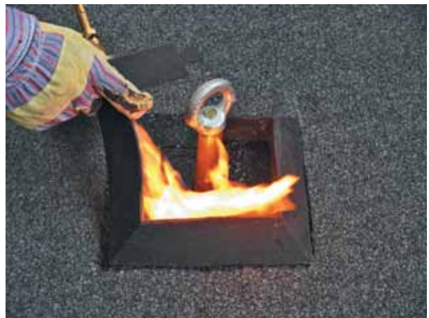
Фото 53 Установка полимерной рамки.
