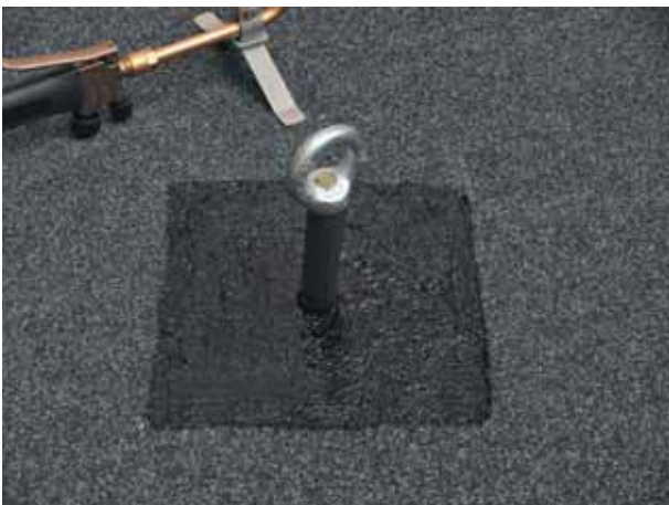
Фото 52 Втапливание посыпки в месте установки рамки
