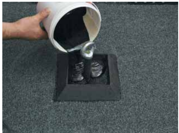
Фото 54 Заливка рамки битумно-полиуретановым герметиком
